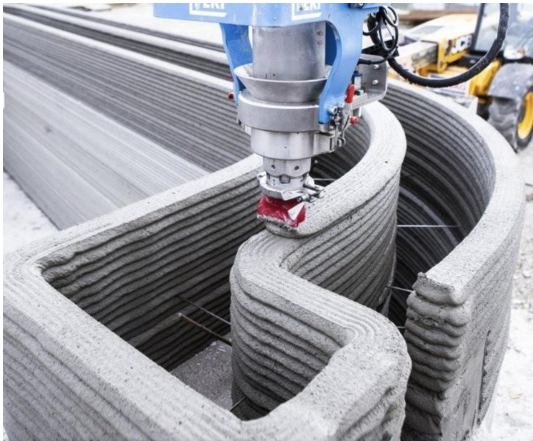
Рис.1.8 – Друкування фасаду будівлі
